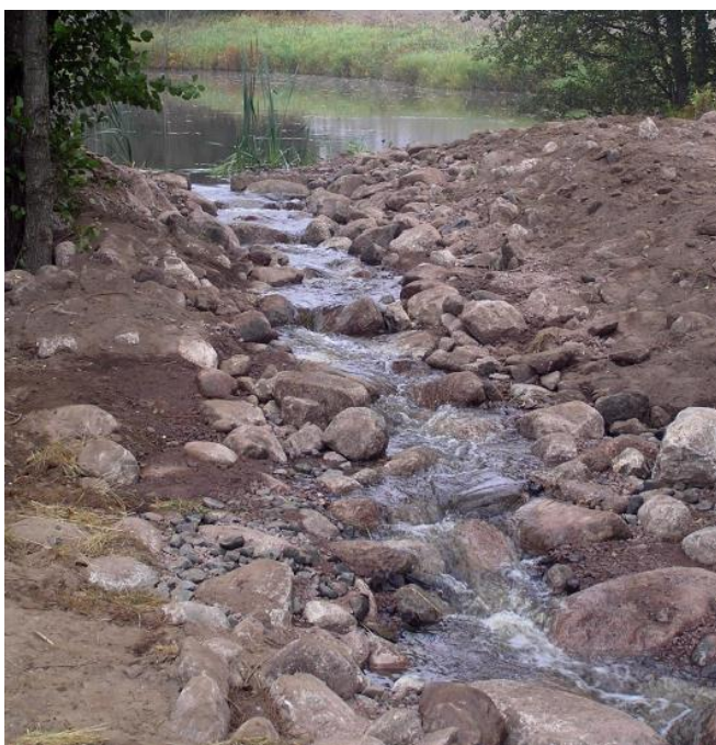
Figur 9. Naturlig steinterskling ("rocky ramp") anlagt i bekk med V-profil for å forenkle oppvanding. Foto hentet fra (Havs- og vattenmyndigheten, 2013).
