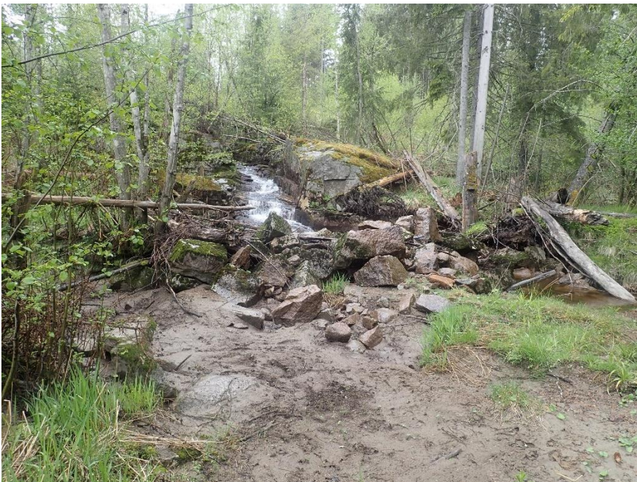
Figur 4. Steinrekke nedstrøms kulpen stuver opp vann i utløpskulpen til renna.
