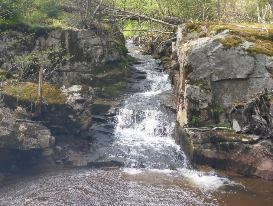
Figur 1. Nedre del av utsprengt renne i Rimstadelva. Foto er tatt på lav vannføring.
