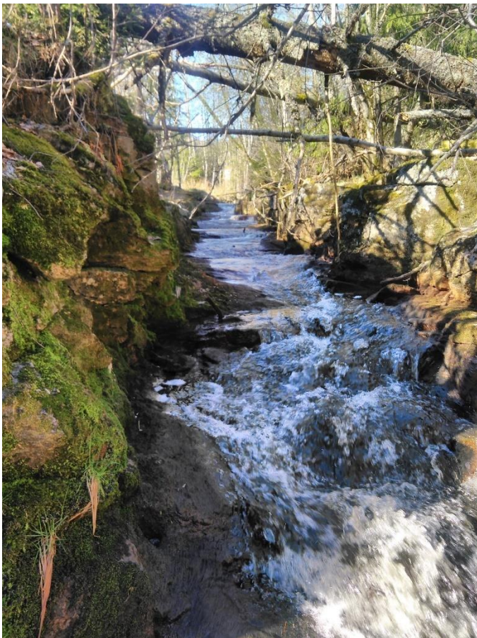
Utskutt tømmerrenne i Rimstadelva vanskeliggjør fiskeoppvandring.
